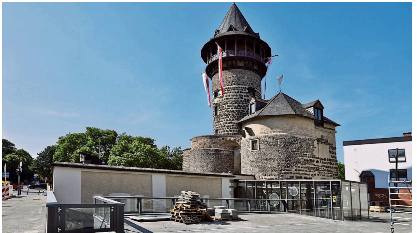
Der unterirdische Funktionsbau ergänzt die denkmalgeschützte Ulrepforte dezent.
