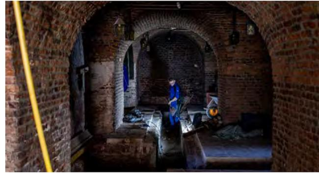
sind die Fundamente unserer Caponniere. Vier Tage wurde hier durch Basalt gebohrt, bis die Löcher eingebracht waren. Und damit dann im inneren der unteren Wachstube auch weitergearbeitet werden konnte, wurde auch bereits der Fußboden geöffnet und die Schächte für die Lüftungsrohre per Hand ausgeschachtet.
